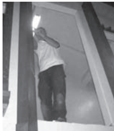
Bill Visscher erecting façade
