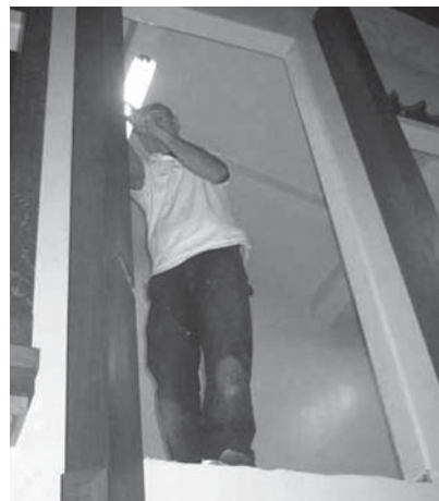
Bill Visscher erecting façade
