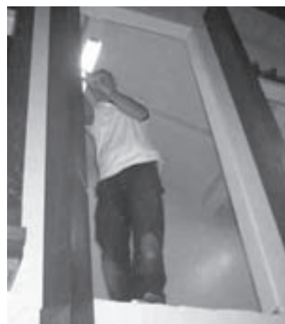
Bill Visscher erecting façade
